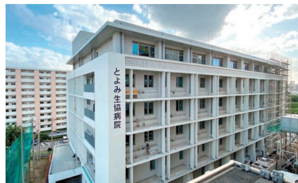
ほぼ完成しているとよみ生協病院の外観
