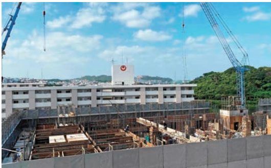
6階の躯体工事中
